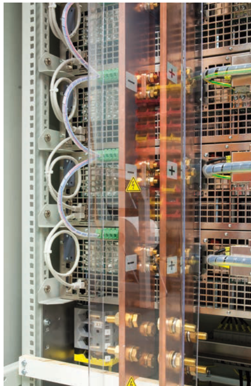
直流总线端子 / DC bus terminal
